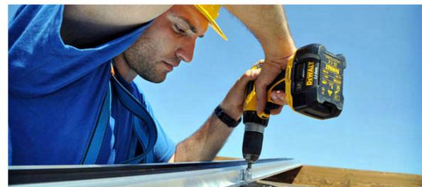
Fissaggio con viti dei profili Solar-Int BD e Solar-Int BS alle travi secondarie in legno lamellare
