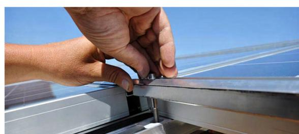
Fissaggio del morsetto centrale Solar-Int MC al dado testa a martello FCN AL con la vite TCEI in acciaio inox A2
