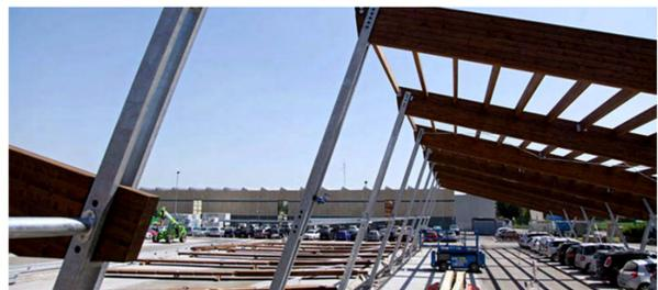
Vista della struttura portante in legno lamellare ed acciaio
