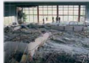
Nel 1985 a Uster, Svizzera, il controsoffitto in cemento di una piscina coperta cedette. Le sospensioni del soffitto in acciaio inossidabile non mostravano esternamente alcuna imperfezione, ma internamente, la corrosione sotto tensione ne aveva causato la parziale distruzione.
