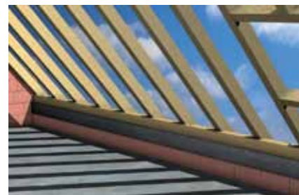
Travi di copertura
