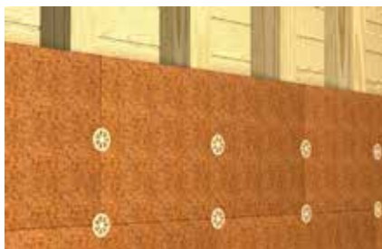
Fissaggio di pannelli in fibra soffice su legno massiccio
