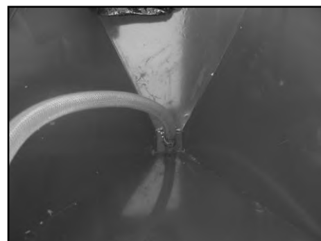
Figura 6 - Collegamento aspirazione sabbia.
