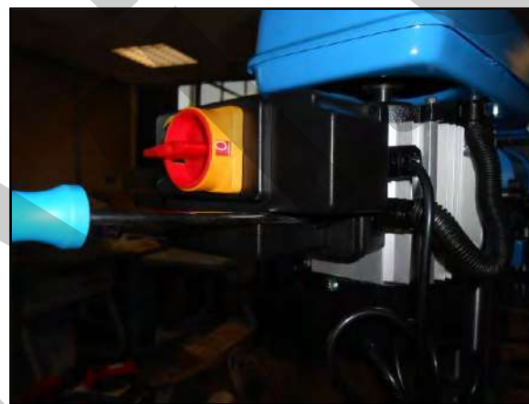
Figura 10 – Montaggio della scatola elettrica.
