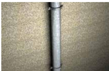
Pluviale a sezione circolare
