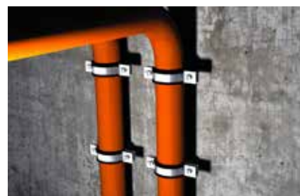
Fissaggio delle condotte in plastica
