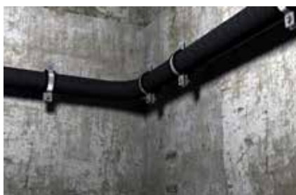
Fissaggio delle condotte in plastica
