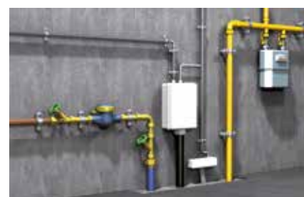
Fissaggio delle condotte
