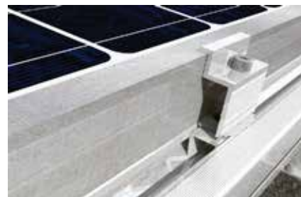
Dettaglio: fissaggio del modulo fotovoltaico
