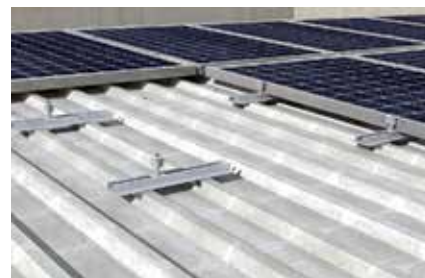
Installazione su copertura industriale con P 400
