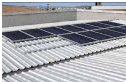
Copertura industriale in lamiera grecata
