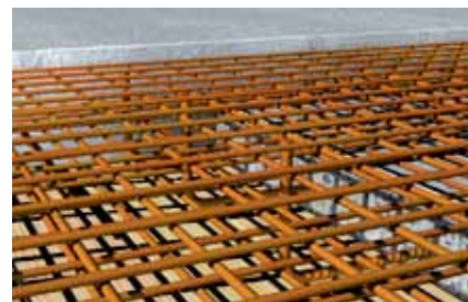
Connessioni di barre di armatura
