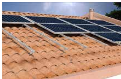
Struttura speciale su copertura a falda
